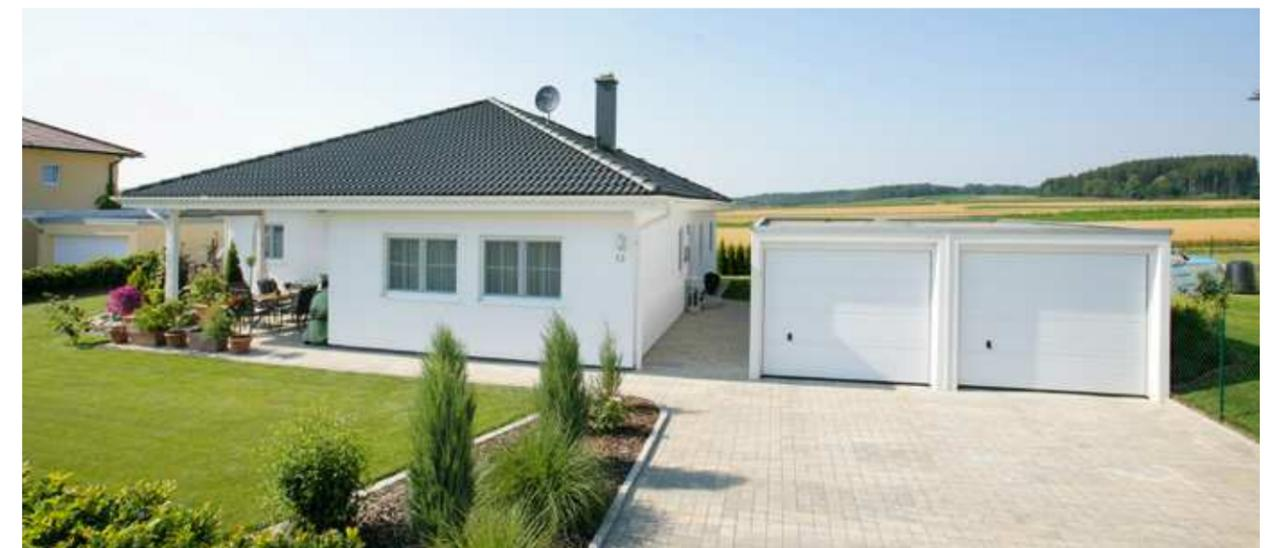
Separate Doppelgarage aus Betonfertigteilen
