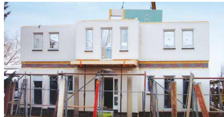
Anschließend wird das Obergeschoss aufgesetzt.
