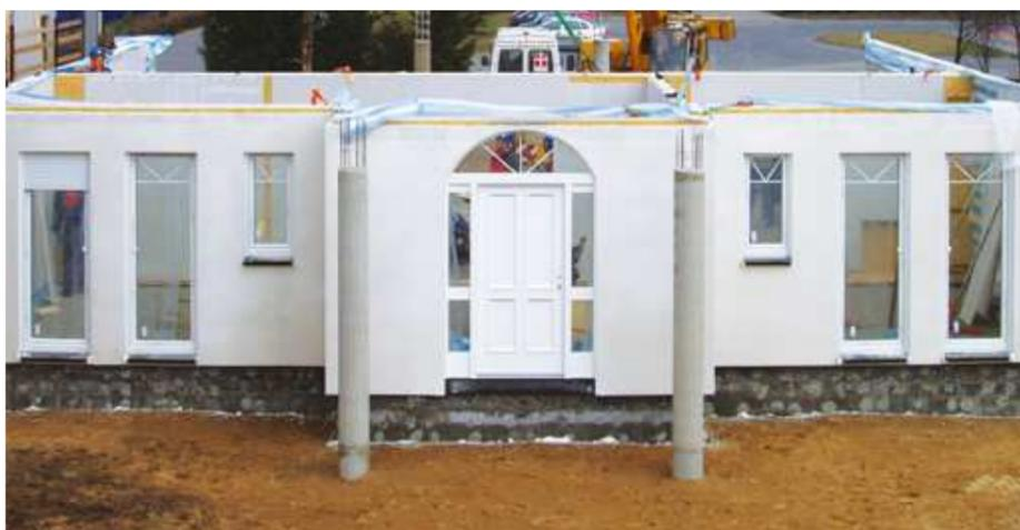
...und das Erdgeschoss auf das Fundament montiert.
